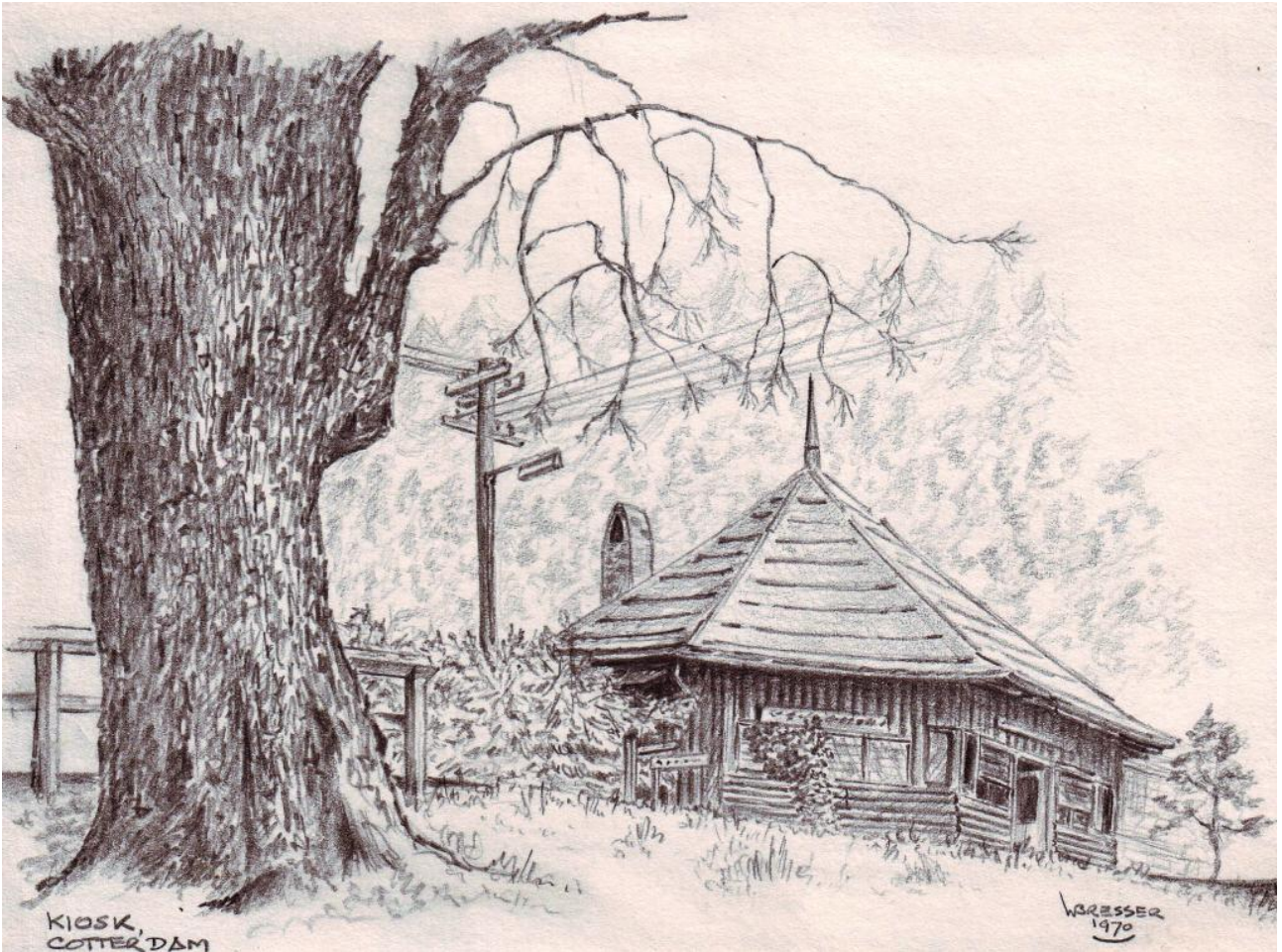
Kiosk, Cotter Dam (1970)
